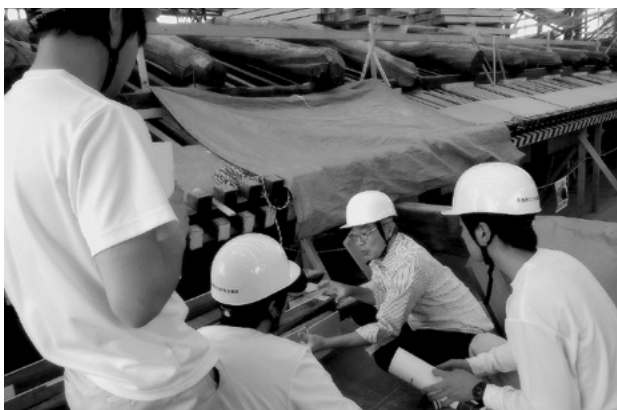
修理現場での研修
