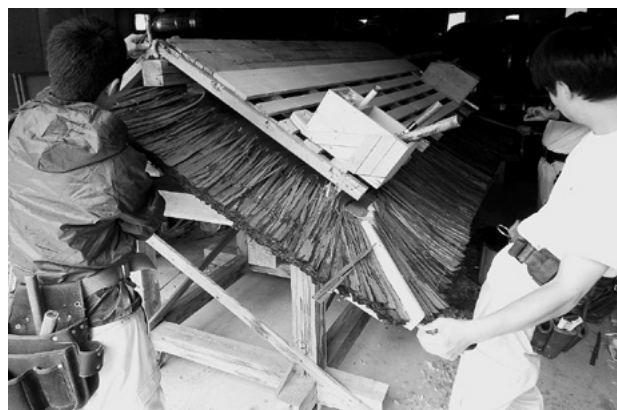
屋根模型の葺実習
