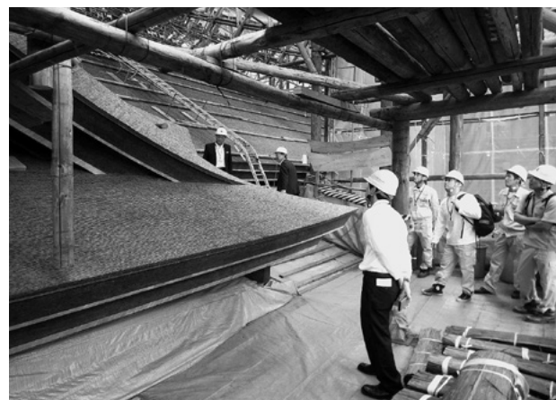
仮設足場の上に行って見学する参加者
