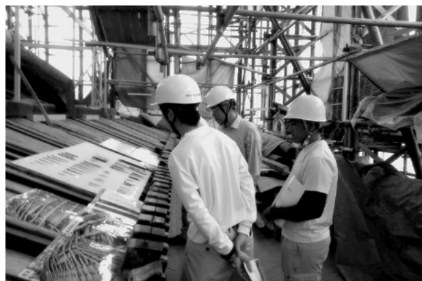
修理現場での研修
