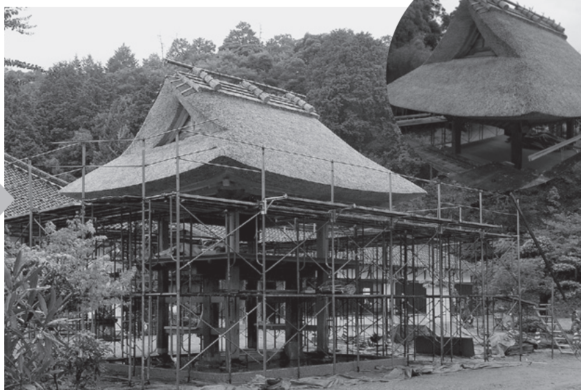
葺き替えを終えた安養寺鐘楼門
