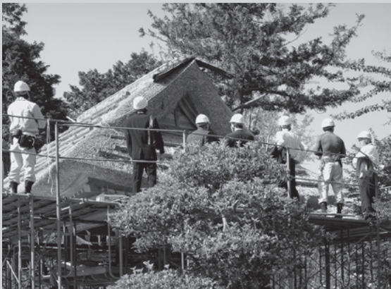
修理現場見学
