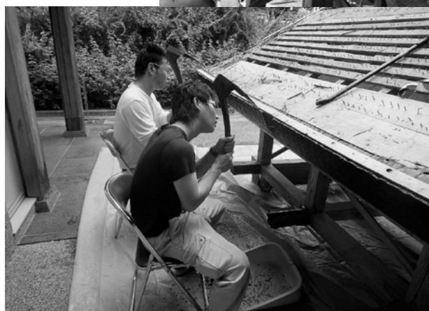
檜皮葺屋根模型の軒切り実習
