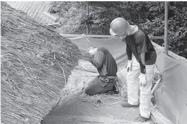
指導員による軒下の補修指導
