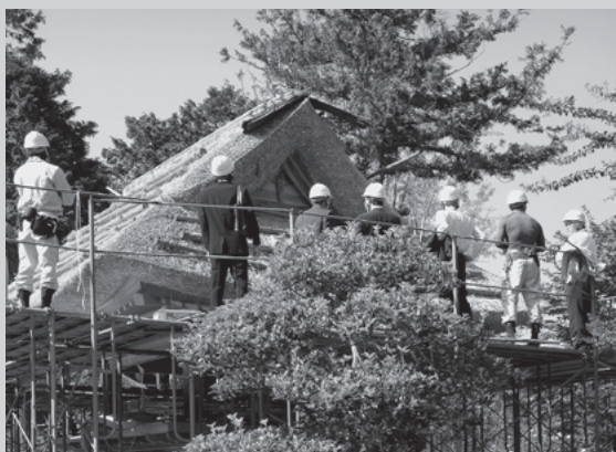
修理現場見学
